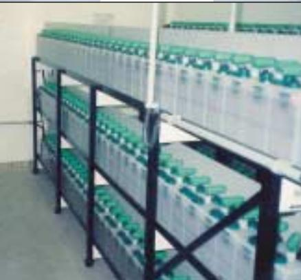
Les éléments FNC® sont fabriqués en plusieurs modèles et sont souvent utilisés dans des installations d'alimentation de sauvegarde secteur.
