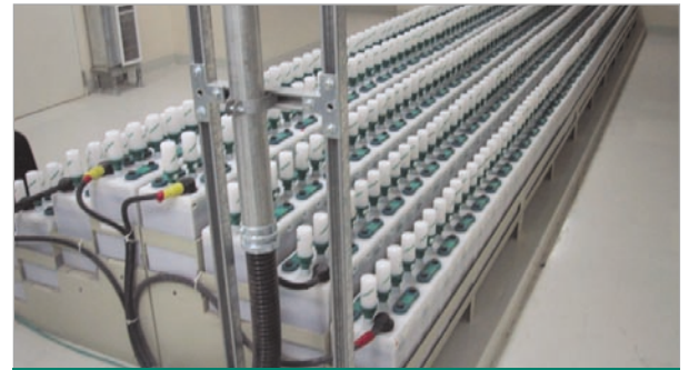
FNC® stationäres Batteriesystem
